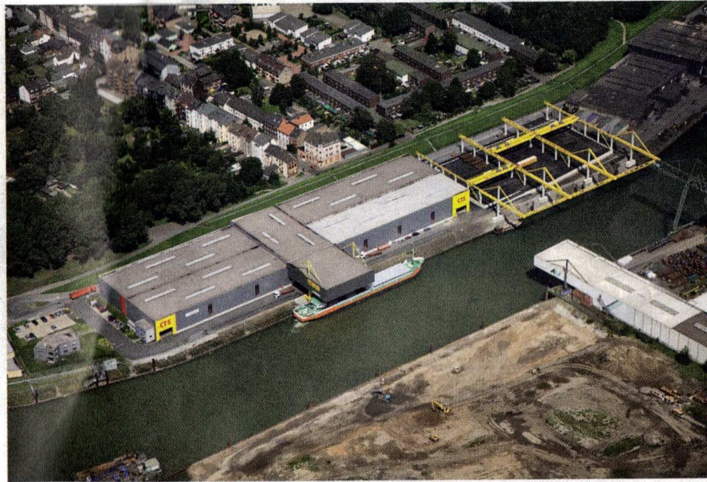
Fünf Hallen und ein Freilager bilden den Kern der CTS-Anlage.
